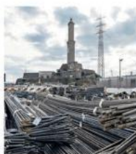
Il cantiere per il nuovo tunnel
